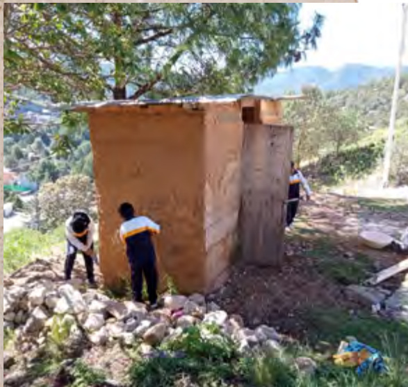
Restauración de baño seco en la Telesecundaria José María Pino
