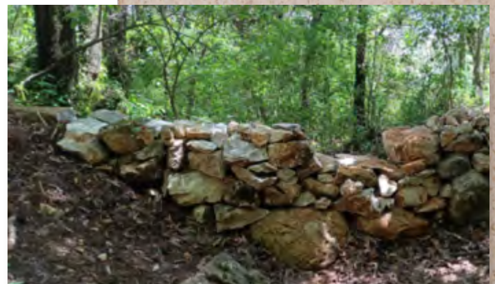
Barrera de piedra para reducir sedimentos por arrastre en Reserva Moxviquil
