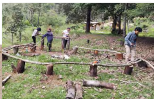
Renovación de los espacios de descanso y campamento con jóvenes de servicio social
